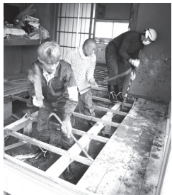
汚泥の撤去作業
